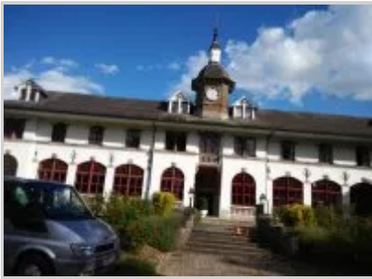
Průčelí budovy CTS
